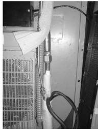
3. 紧固连接管, 安装排水管. 连接电源线后用扎带进行包扎
