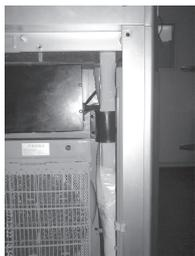
注:由于LP-A7221DDR/W下进风INLET GRILLE 两侧分别带机器人自动清扫部件,所以室内机安装后一定要确认连接管的安装状态,与空气净化和下进风INLET GRILLE不要贴靠,挤压,以免机器人自动清扫功能不能正常运转,产生噪音。
