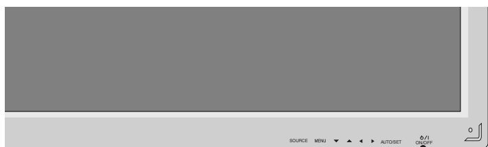
TOUCHE DE MISE SOUS/HORS TENSION
