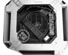
(2) تركيب منتج DUCT PCB المزود ← استخدم حامل PCB المزود
